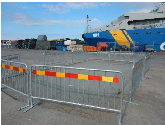
Foto 38, återställd yta efter utförande
