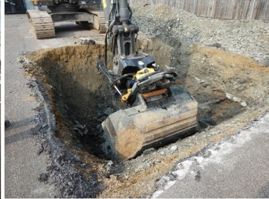
Foto 2 och 3, schaktning provgrop PG 1 utanför kajskjul 107
