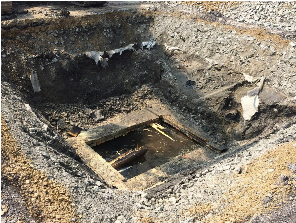
Figur 1. Bild på PG1601. Hål har tagits upp i rustbädden av trä.
