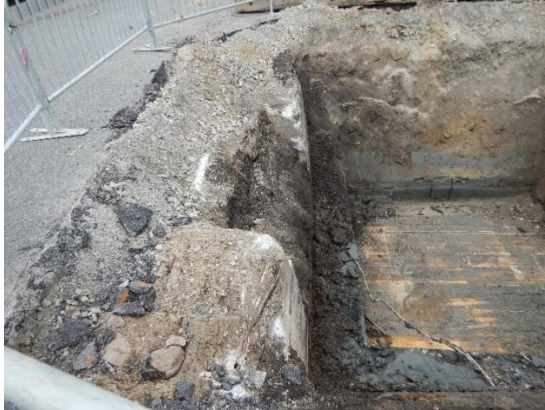
Foto 13, provgropens sydvästa hörn, betongfundament från gamla konstruktioner
