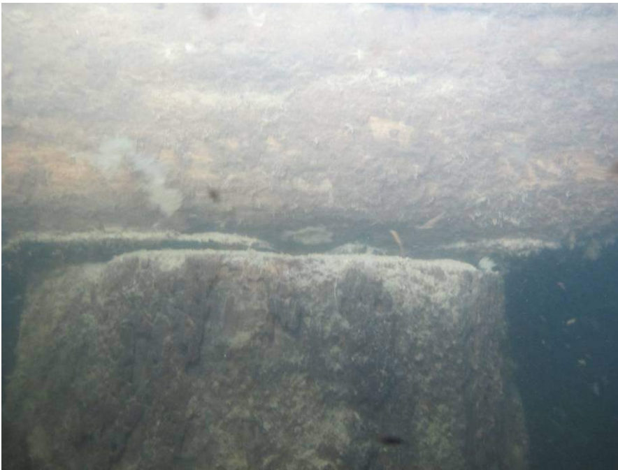
Topp av träpåle med överliggande träbalk
