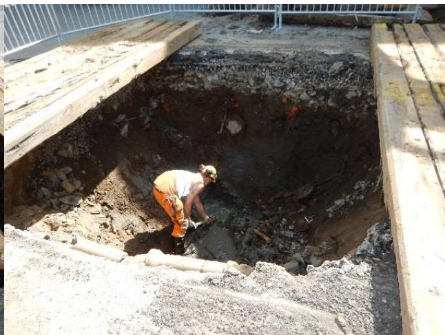
Foto 27 och 28, handschakt runt påle för dragprov. Ledning i schakt var ej i funktion
