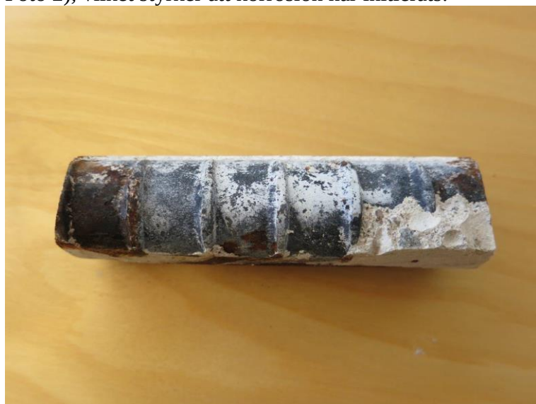
Foto 2. Armeringsjärn från kärna 2 (djup 45-80 mm från ytan), där det finns rostfläckar.
