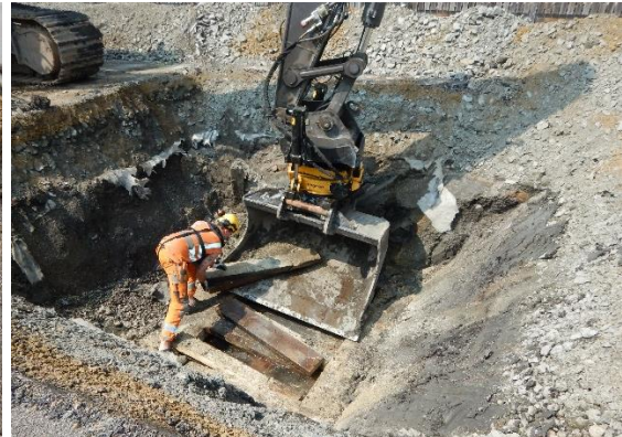
Foto 5, virke rustbädd tas upp
