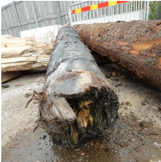
Foto 20, brottytan av en dragen påle
