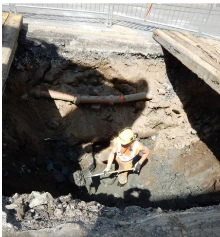
Foto 27 och 28, handschakt runt påle för dragprov. Ledning i schakt var ej i funktion
