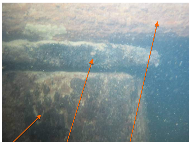
Träplåle mellanlägg överliggande träbalk
